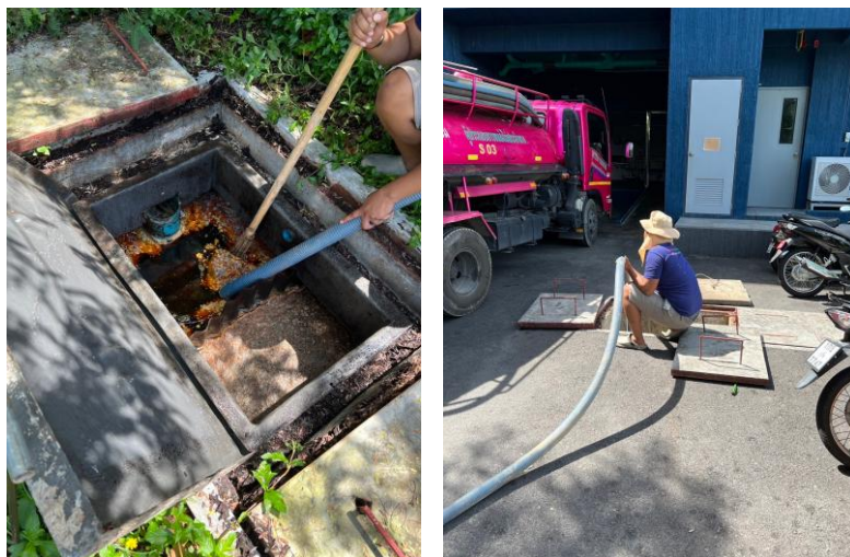
รูปภาพที่ 2.44 การสูบน้ำตะกอน
